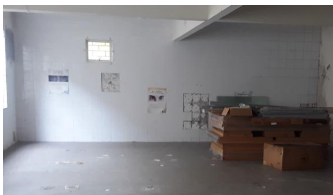
Parede que deve ter o revestimento cerâmico retirado
