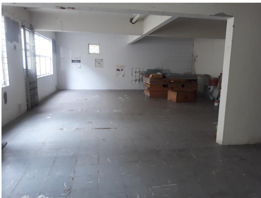
Vão que deve ser fechado com parede de gesso acartonado
