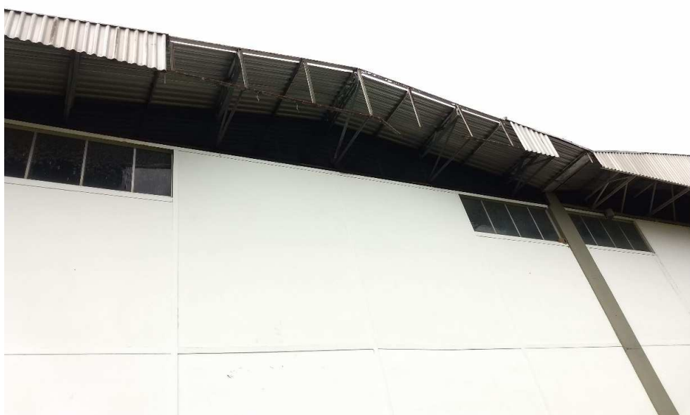
Foto 14– Local de colocação da platibanda e recuperação da estrutura metálica
